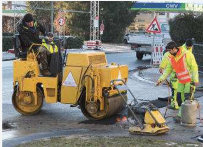
Kurz vor der Weihnachtspause der Glasfaser-Ausbauarbeiten wurden und werden noch alle Straßen und Gehwege winterfest gemacht – hier beispielsweise am 18. Dezember in der Münchner Straße (Foto: Deutsche Glasfaser)
